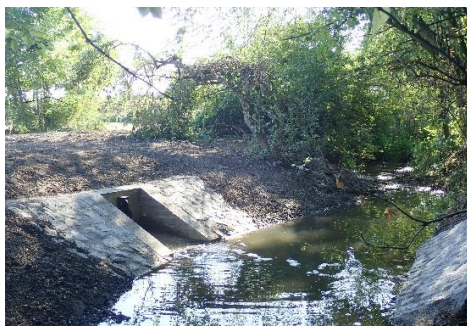
Obr. 1 Vyústění předčištěné odpadní vody z ČOV Jabkenice do Jabkenického potoka pod rybníkem Záhumenní velký (Foto: Chmelický, 2018).
